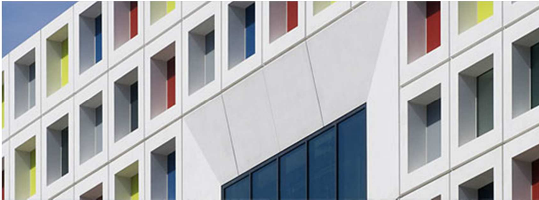
Abbildung 26: Dyckerhoff GmbH, Zement und Transportbeton sowie „Dyckerhoff WEISS“ für nachhaltige Betonapplikationen und Sichtbetonanwendungen.
