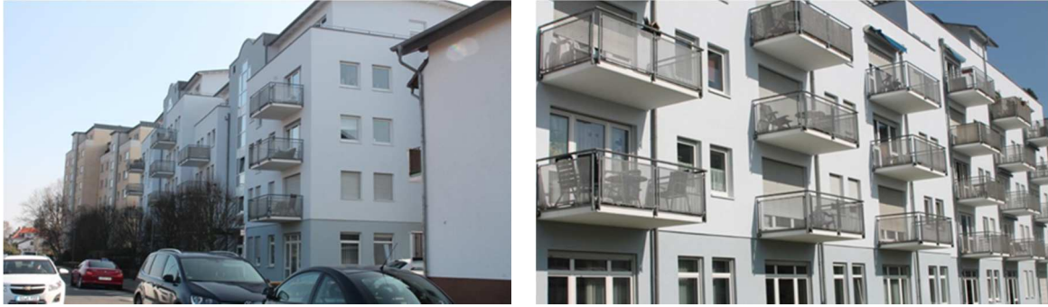
Abbildung 24: KEIMFARBEN GmbH, nachhaltige ökologische Fassadengestaltung, Wohnbebauung, Heegstrauchweg, Gießen ausgeführt mit KEIM Soldalit-ME.
