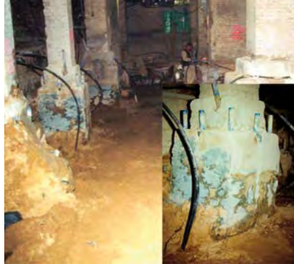
Underpinning, Staatsbibliothek Berlin
