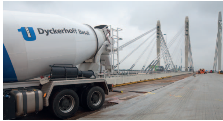
Fig. 10: Le pont Ewijk (photo: Bart van Hoeck)
