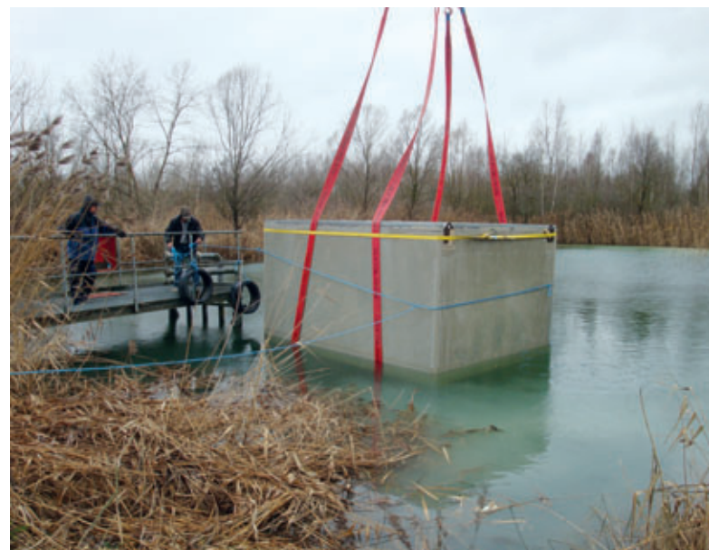
Abb. 6: Betonponton aus verklebtem Hochleistungsbeton
