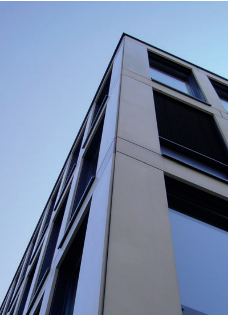
Abb. 10: Vorhangfassade der Ferchau Firmenzentrale, Deutschland
