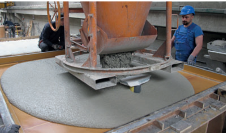
Abb. 12: Betonage mit selbstverdichtendem Drössler Ultralith SG
