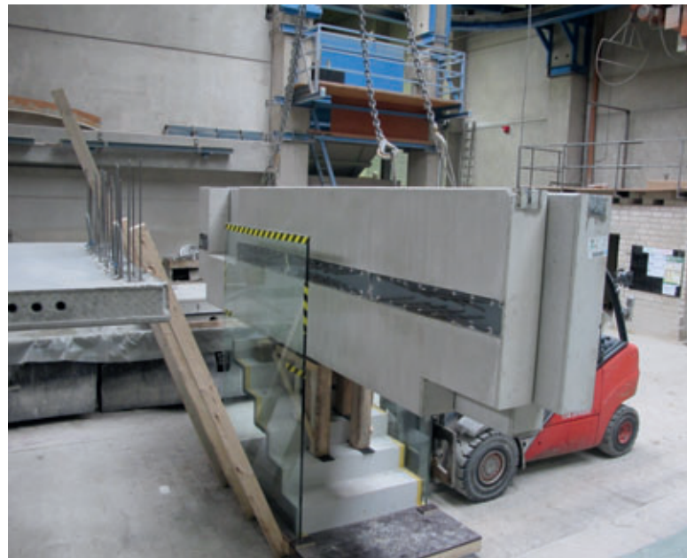
Abb. 3: Belastungstest Fertigteilwerk Drössler, Deutschland
