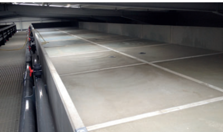
Abb. 16: Fertiggestelltes oberes Becken
