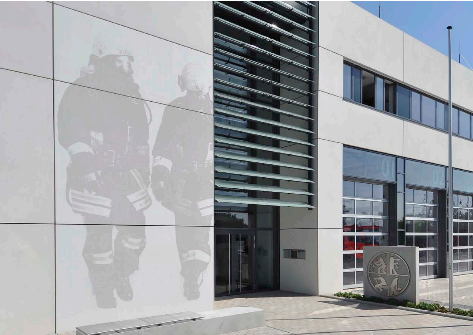
Hier steckt unser Zement drin: Fotobeton auf der Außenfassade der Feuerwache Langenfeld (Bildnachweis: BetonBild, Erkrath/Hering Bau GmbH & Co. KG, Burbach)
