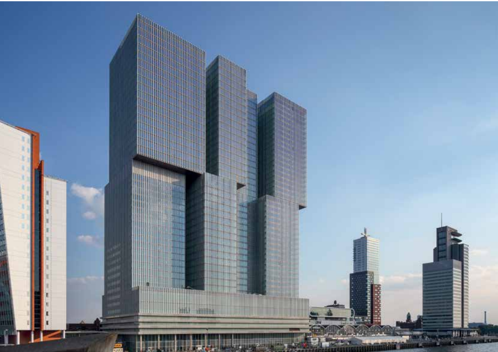
Hier steckt unser Zement drin: De Rotterdam, Niederlande
