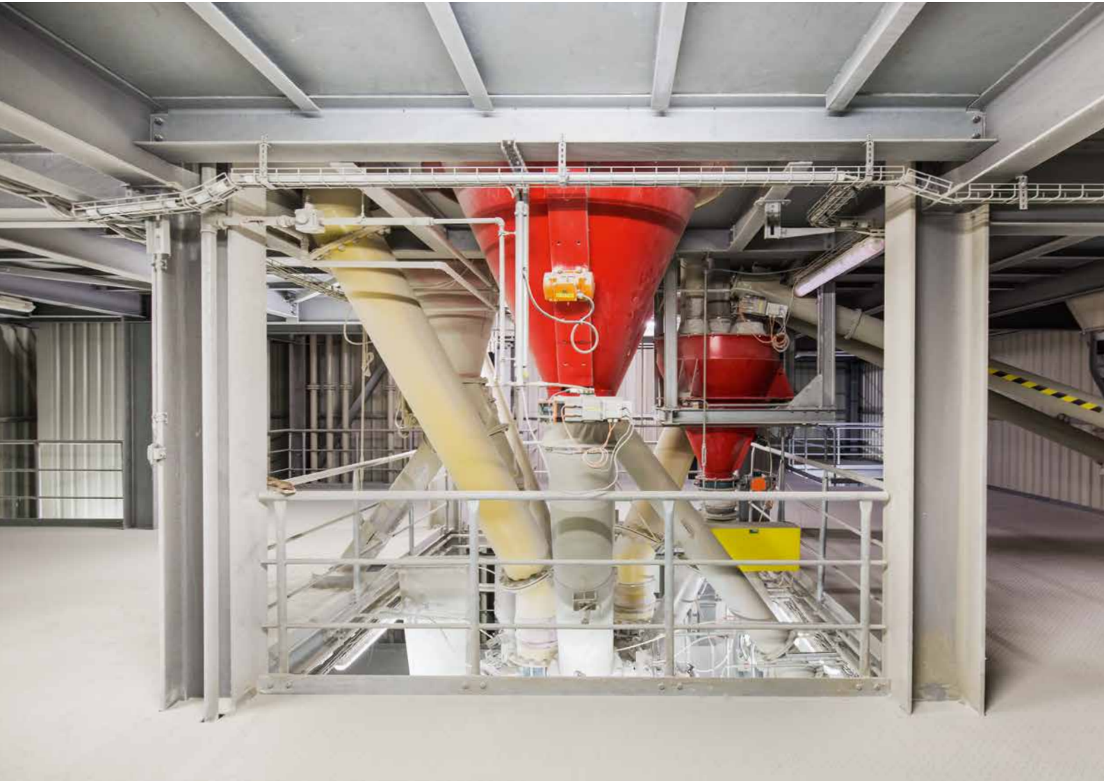
Neu entwickelte Mischanlagen ermöglichen uns die Herstellung einer Vielzahl von Zementsorten
