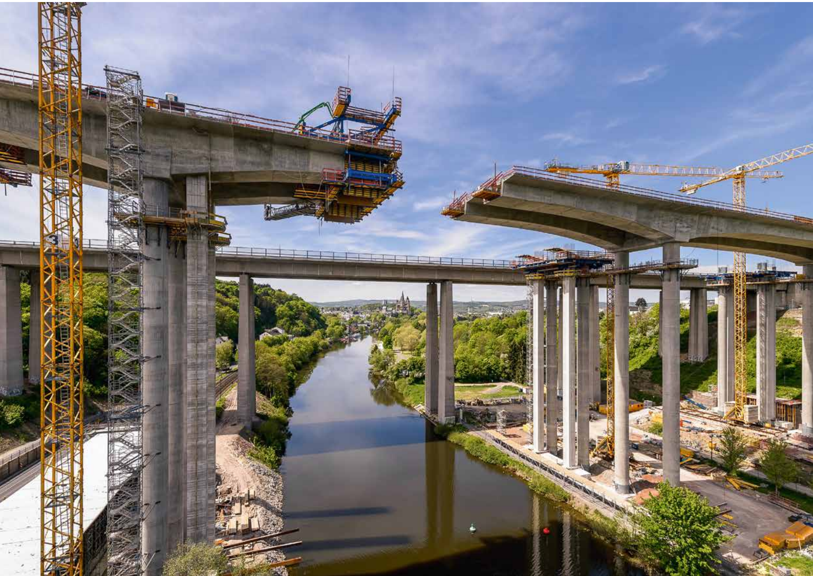
Hier steckt unser Zement drin: Lahntalbrücke bei Limburg
