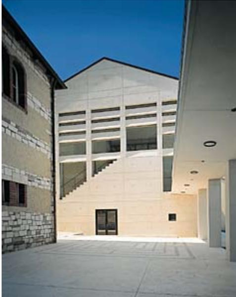
*Weissbeton mit abgedichteten Schalungsstößen hergestellt.*
