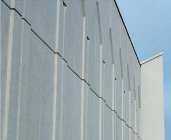
*Betonfertigteile aus Weissbeton in Stahlschalung produziert.*
