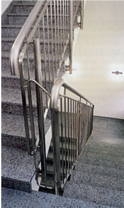
Trittschallgedämmte Betonwerksteinbeläge im Wilhelm Dyckerhoff Institut in Wiesbaden.
