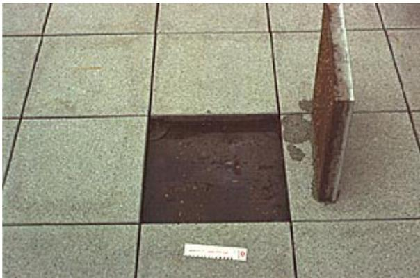
*Feuchteränder bei verlegten Betonwerksteinplatten ohne ausreichende Entwässerung des Untergrundes.*
