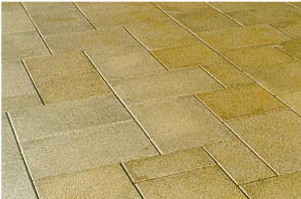
*Eine Form von Farbunterschieden ist die Verschmutzung von Terrassenplatten durch Böden mit hohen Feinstanteilen.*
