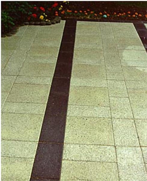
*Unterschiedlich stark verschmutzte Betonwerksteinplatten mit unterschiedlichen Wasseraufnahmen.*
