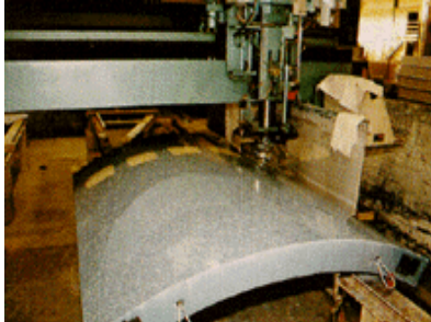
Das Schleifen und Polieren von Grobelementen, Stützen mit Kreisquerschnitt oder auch Flächenelementen mit gekrümmten Oberflächen sind inzwischen Stand der Technik
