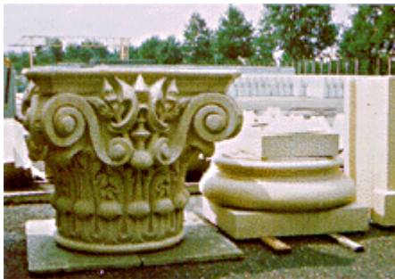
Bei der Instandsetzung des Kurhauses in Scheveningen wurden Bauteile in farbigem Beton dauerhaft nachgebildet
