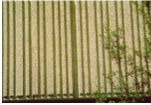
Vertikal kanalisierende Profilierung der Oberflächenhilft Ablaufspuren zu vermeiden
