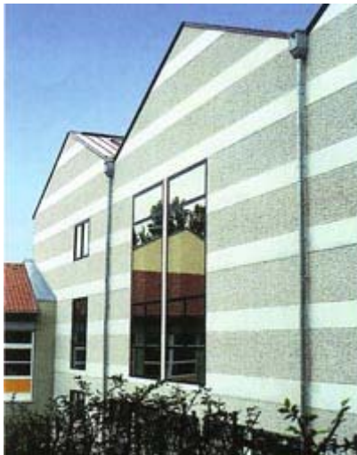
Glatt geschalte, mit Spitzmeisel in Felder bearbeitete Betonfassade (Gemeindezentrum, Regensburg)
