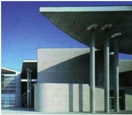
Gelungene Kombination vorgefertigter und vor Ort gegossener Betone (Kunstmuseum Bonn)
