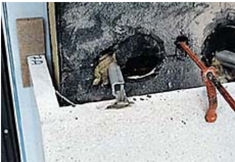
Einzelanker in Mörtel gesetzt
