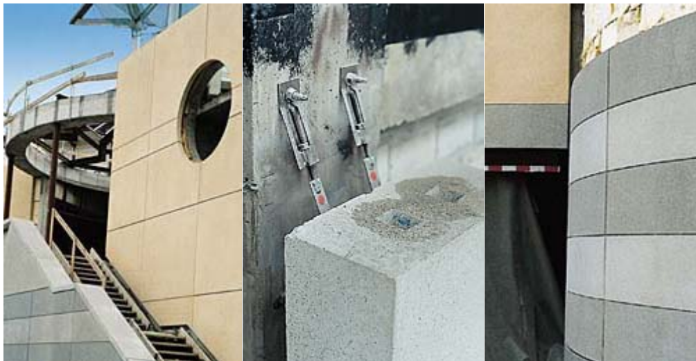
Großformatige gesäuerte Betonfertigteile auf der Baustelle
