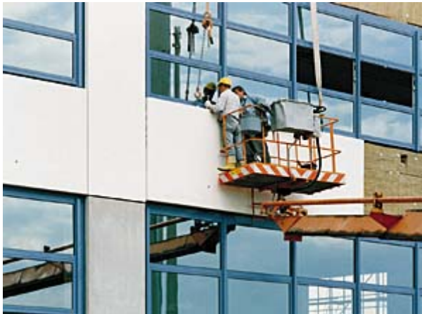
Montage einer Fassadenplatte
