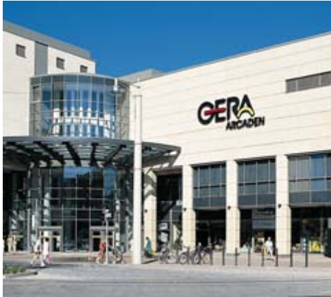
Sandwichplatten mit feingewaschener Oberfläche
