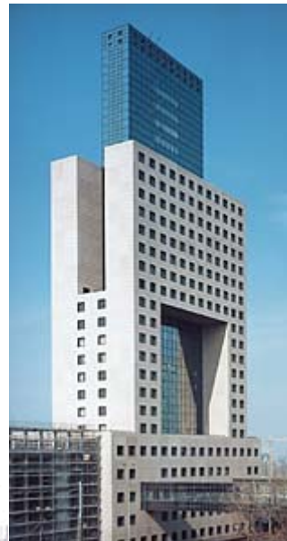
Großformatige, vorgehängte Betonfertigteile mit feingewaschener Oberfläche
