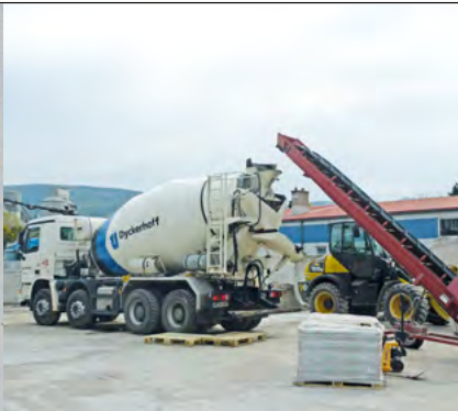
Abb. 23: Stahlfaserdosierung mittels Förderband
