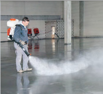
Abb. 32: Nachbehandlung durch Curingmitte
