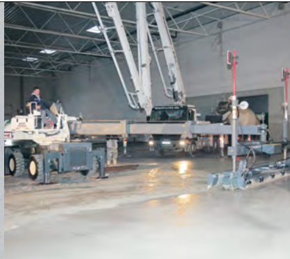
Abb. 30: Betonverteilung mit Laser-Screed
