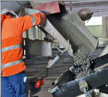
Abb. 29: Betonübergabe in Pumpe
