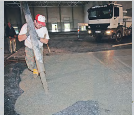
Abb. 28: Einbau Stahlfaserbeton mit Pumpe
