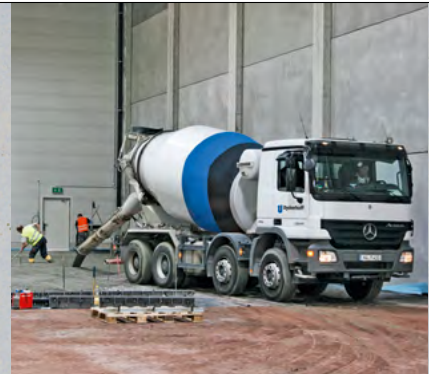
Abb. 14: Direktentladung aus dem Fahrmischer
