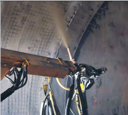
Abb. 16: Stahlfaserspritzbeton im Tunnelbau
