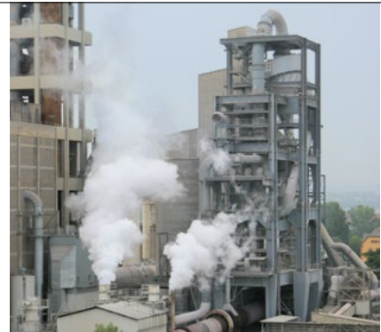
Moderne Dyckerhoff Produktionsanlage für Weisszement am Standort Amöneburg
