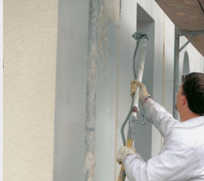
Putz- und Mörtelsysteme auf Basis Dyckerhoff Weiss STRONG überzeugen mit hohen Frühfestigkeiten
