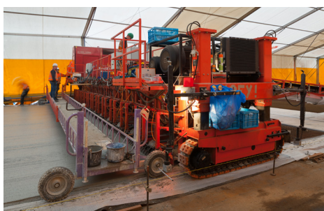
Le finisseur spécifiquement développé permet une mise en œuvre sur 12 m de largeur.
