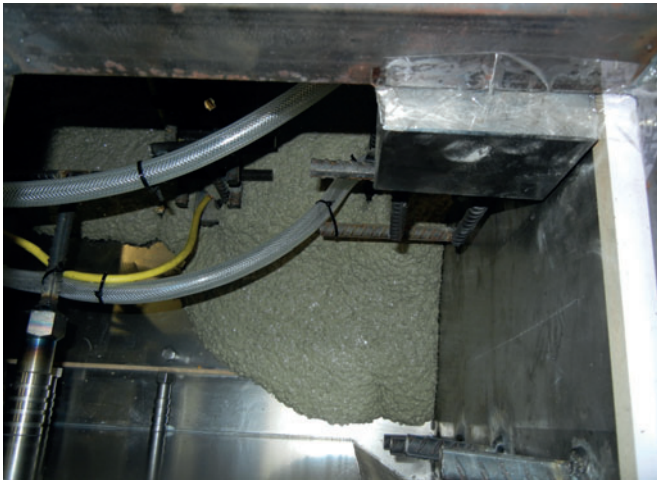
Figure 8 : Coulage dans un moule en acier
