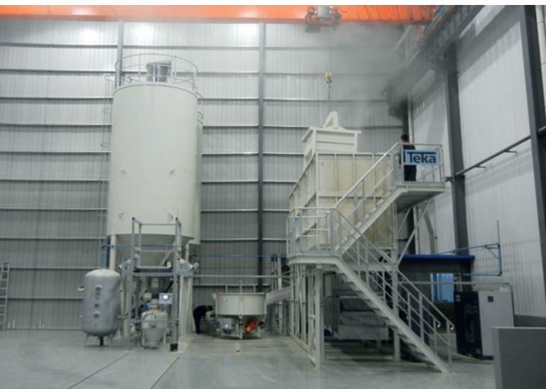
Silos en ligne et silos à ciment
