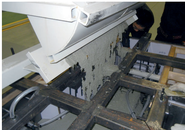
Coulage du premier élément de construction
