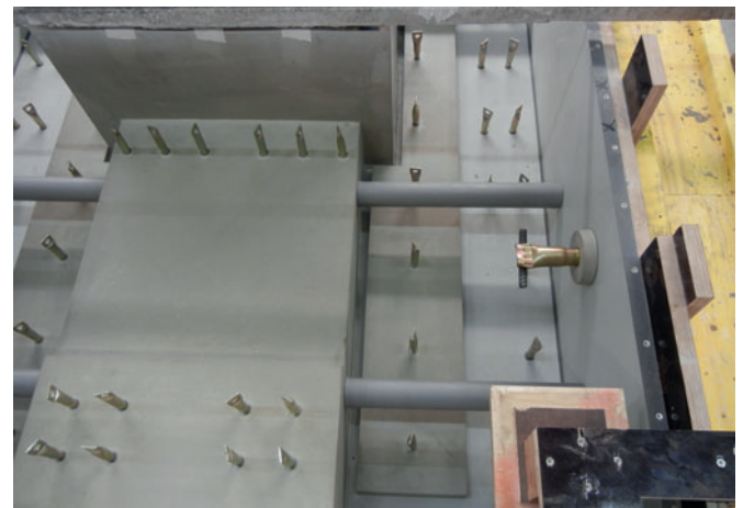
Figure 7 : Éléments incorporés dans un moule en bois
