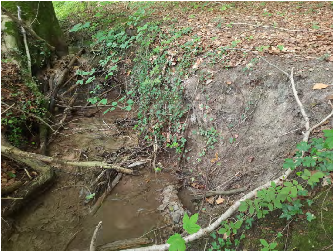
Abb. 27: Frischer Wildwechsel im Umfeld einer Fallstufe (im Hintergrund zu sehen) im Gewässerabschnitt 4 östlich der Sudenfelder Straße, wodurch Uferschäden verursacht wurden, wo zuvor Höhlungen mit Tuffauskleidung existierten (09.07.2024).
