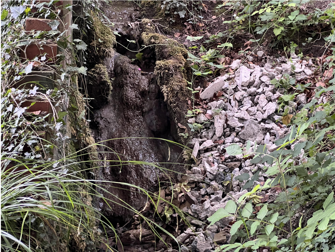
Abb. 30: Die Fallstufe im Mühlenbach am Südende des Grundstücks „Zur Fuchsfarm 13“ im Gewässerabschnitt 5. Zur Uferstabilisierung wurden hier Kreidekalkbrocken angeschüttet (30.07.2023).
