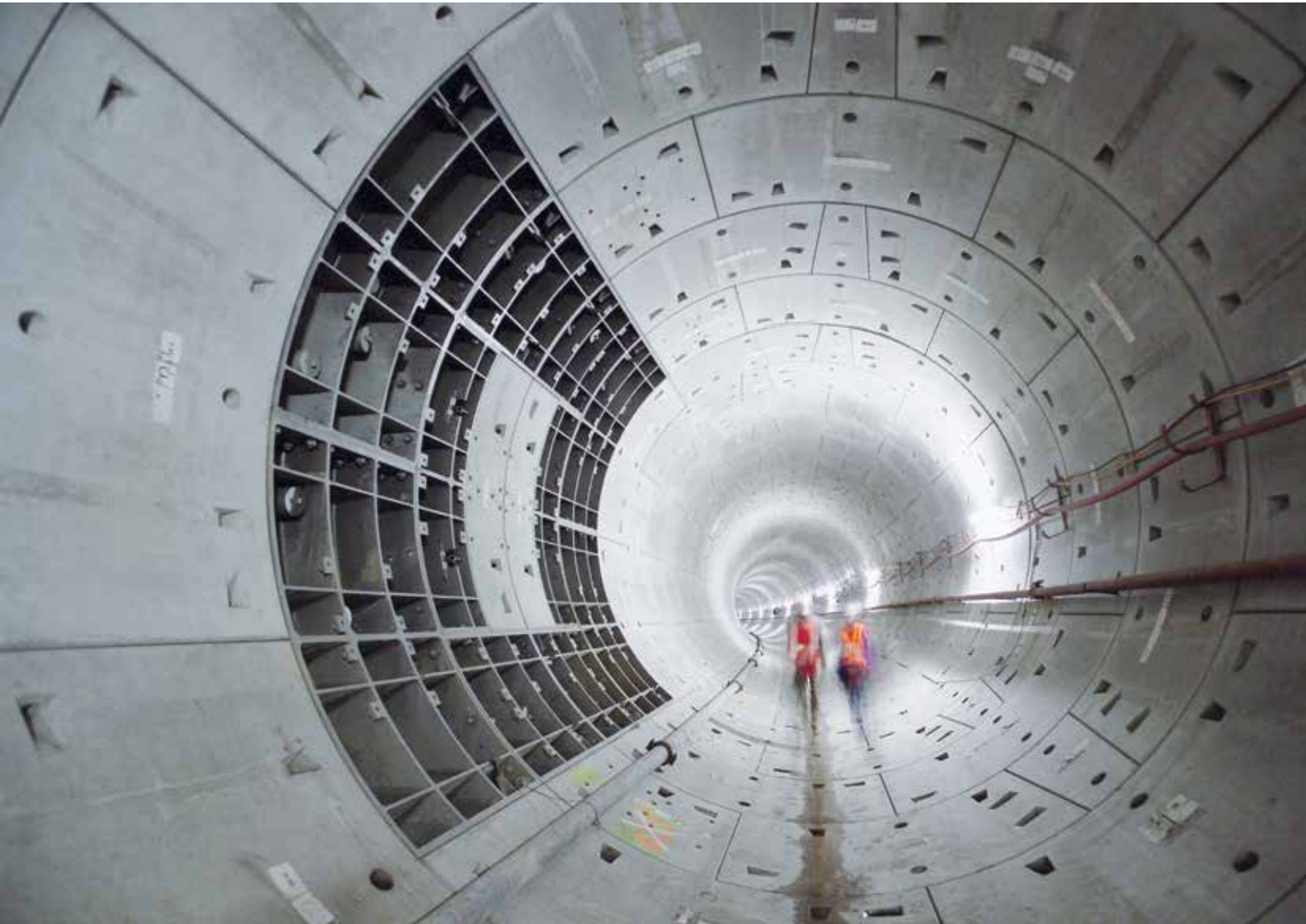
Hier steckt unser Zement drin: Tunnelinnenschalen mit Tübbings bei einer U-Bahntrasse in Rotterdam (Bildnachweis: Rekers Betonwerk GmbH & Co. kg, Spelle)
