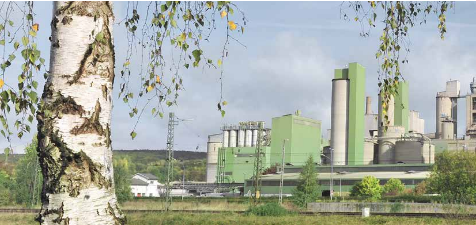
Südansicht unseres Zementwerks
